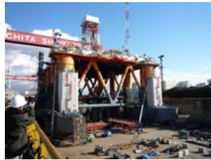
改造工事風景
