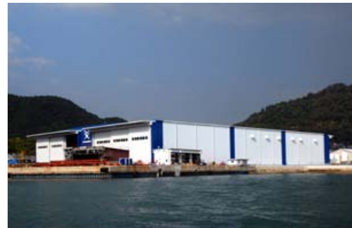
塗装工場の外観
