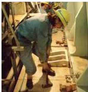
写真 1: 船の心臓“エンジン”(1500t)を据え付ける作業を行う筆者
