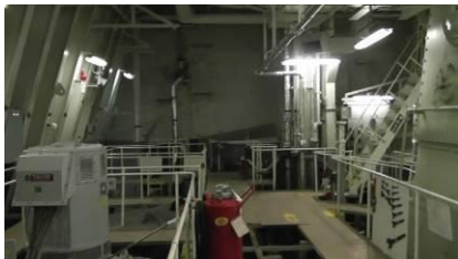
【BWTS 搭載施工前】
