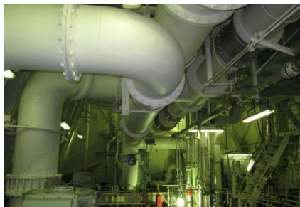
【BWTS 搭載施工後】
