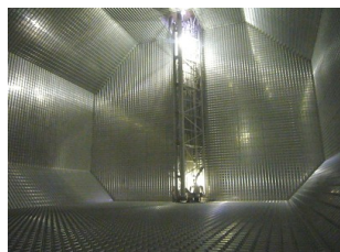
LNGタンク内
