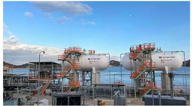
【アンモニア燃料供給装置】
